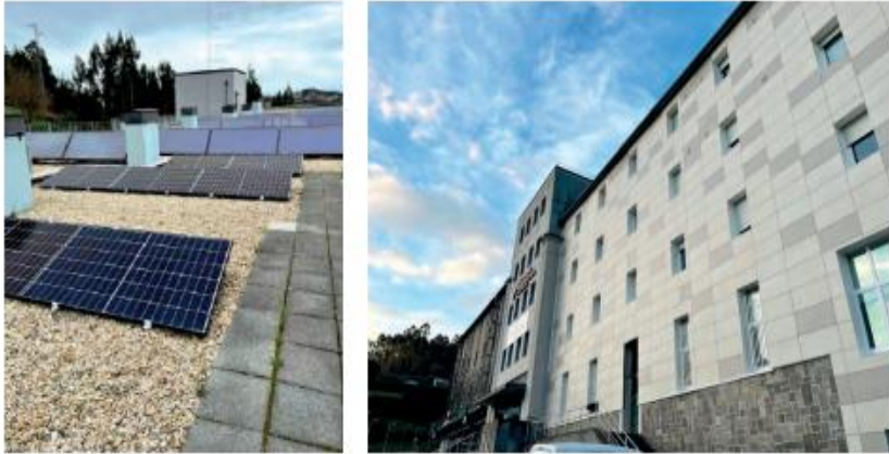
Paneles solares y fachada nueva
